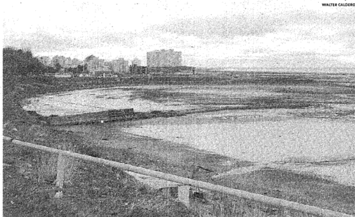
EL PROYECTO AFECTA UNA AMPLIA FRANJA SOBRE PLAYA SUR. SE RELLENARÁN CON TIERRA 54 MIL METROS CUADRADOS.
