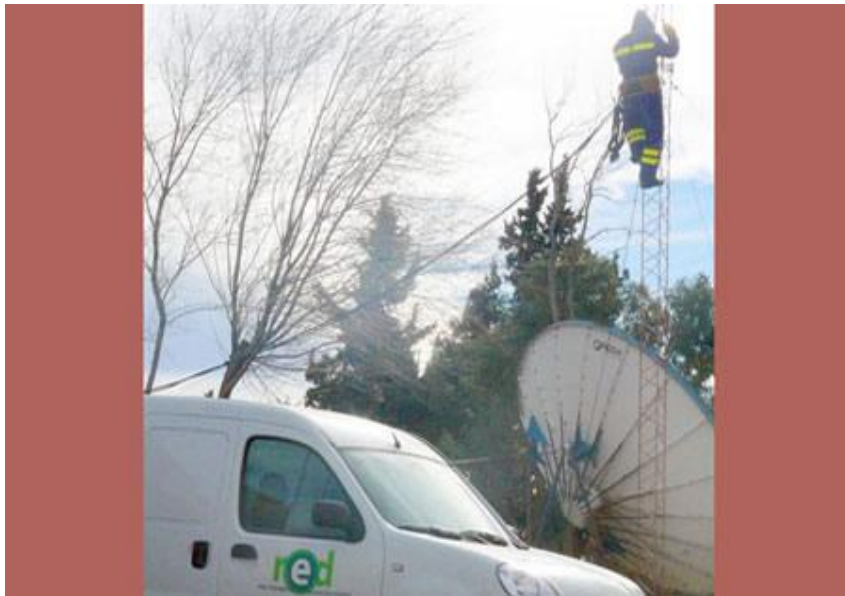
1 - Personal instalando el sistema WI-FI.
