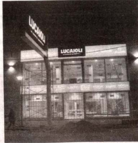
La obra será entregada este fin de semana a la empresa.
