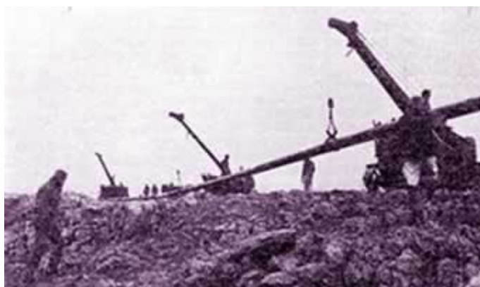
El ex gasoducto sería utilizado para transportar agua.
