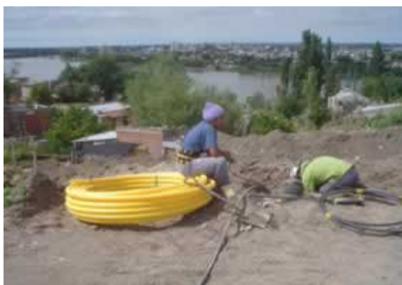
Actualmente se está tapando la zanja.
