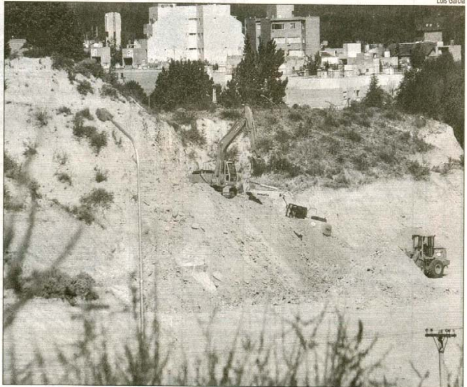
Impresionante trabajo de movimiento de suelo en la zona de las bardas. En ese lugar se construye el nuevo centro comercial de la capital.
