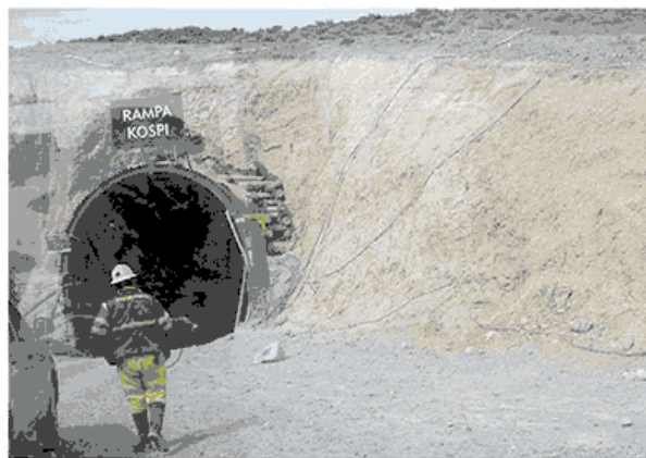
Rampa Kospi, mina subterránea donde se explota plata y oro.
