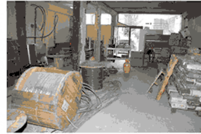
Por estos días los trabajos se concentran en las instalaciones eléctricas y redes de servicios.
