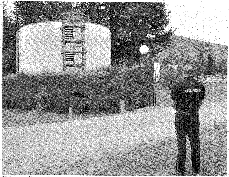
TENSA CALMA. HAY PERSONAL DE SEGURIDAD EN EL INGRESO A LA PLANTA POTABILIZADORA DE ESQUEL.
