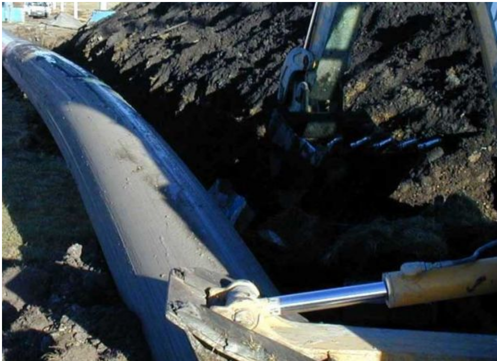
Los trabajos marchan de acuerdo a lo establecido. Galería de Fotos
