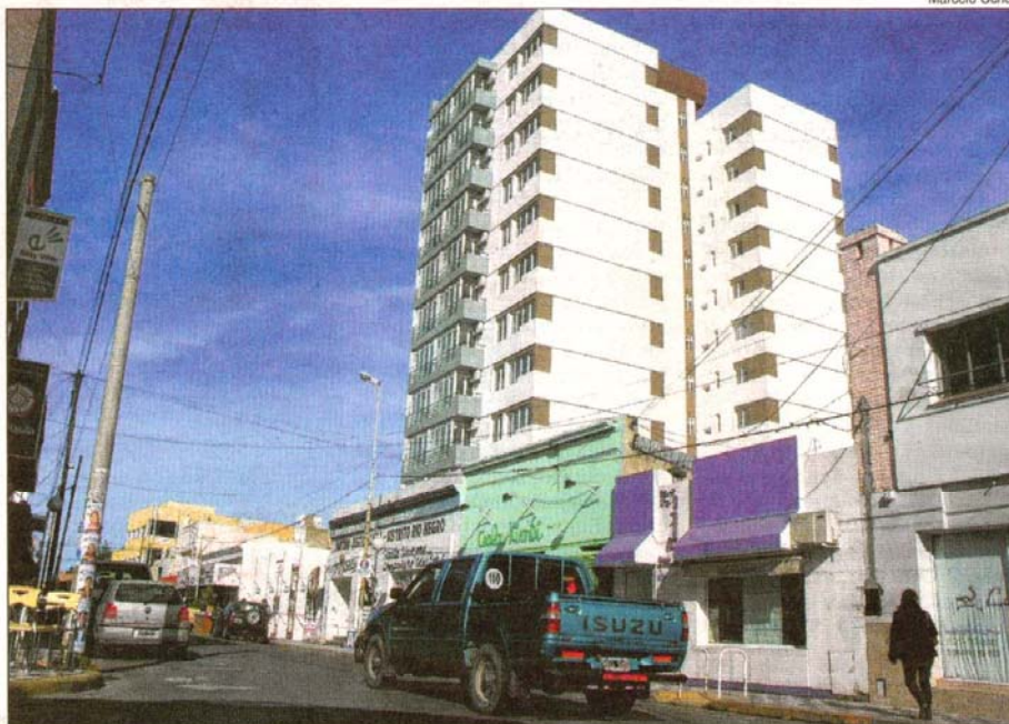
El moderno edificio está emplazado en Buenos Aires 53, de Viedma.
