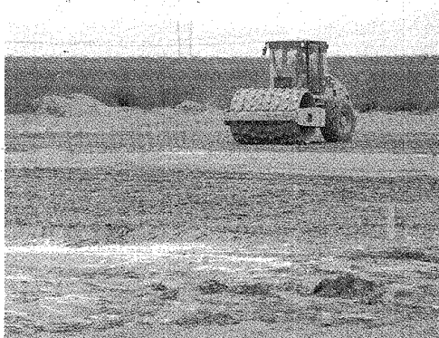
EL TRABAJO DE LAS MÁQUINAS VIALES ES UNA CONSTANTE EN EL SECTOR.
