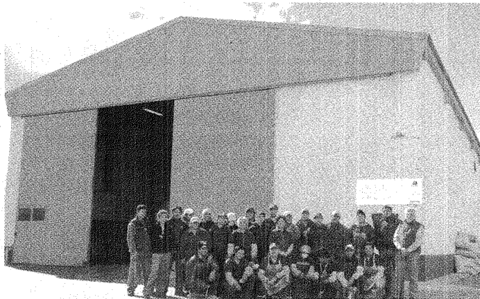
CON TODOS. LOS TRABAJADORES FRENTE A LA PLANTA DE TRATAMIENTO CORDILLERANA.
